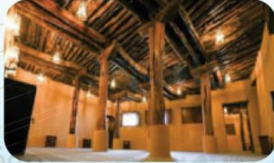
مسجد تاريخي بعد ترميمه
